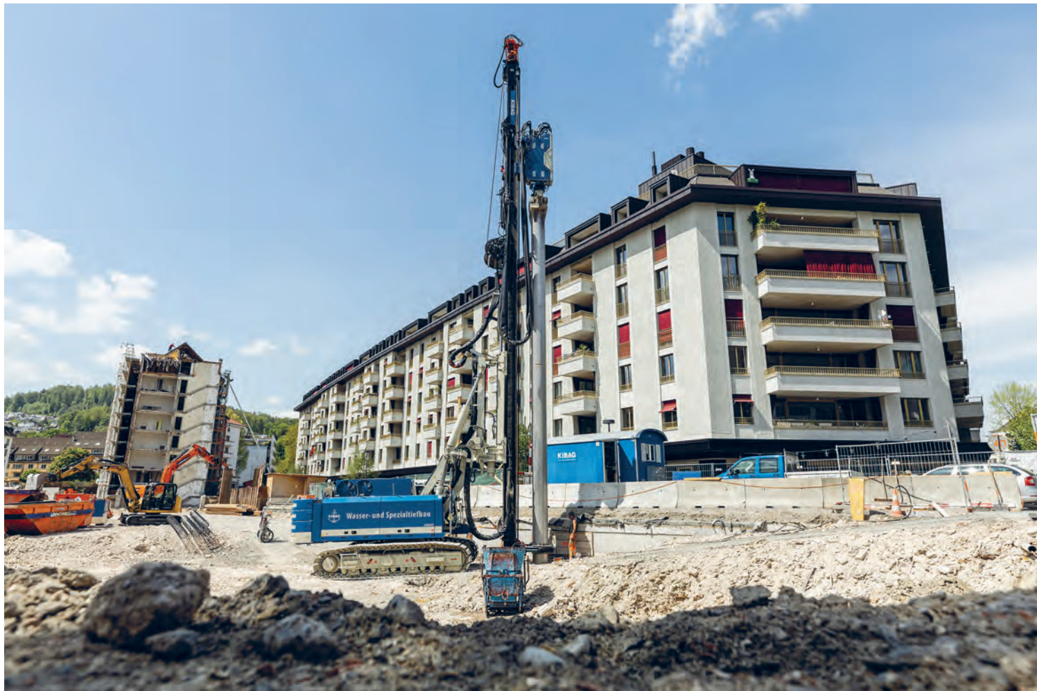
Baustelle der zweiten Etappe: Die alte Claridenstrasse wird rückgebaut, für die neue wird gepfählt.
