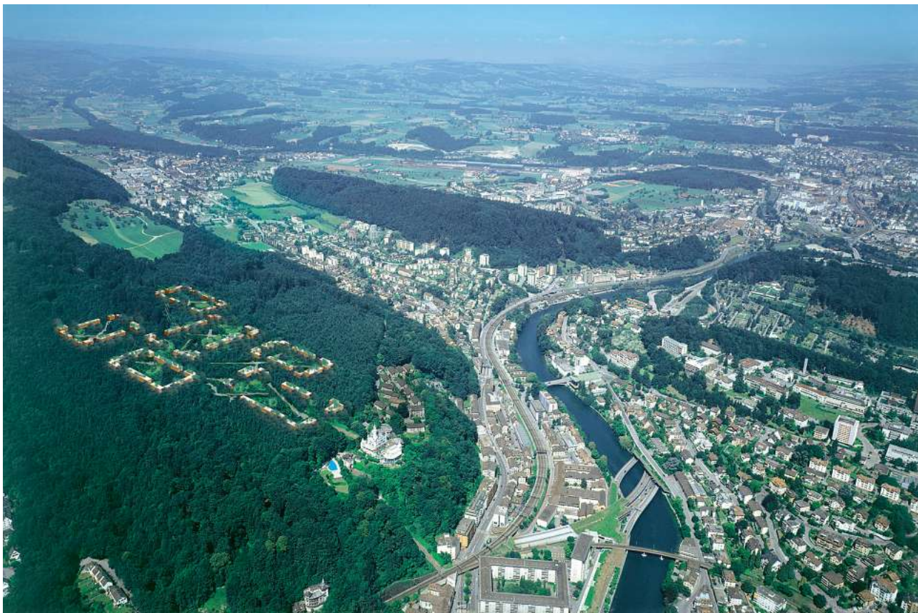
Darf wohl je im Gütschwald gebaut werden?
