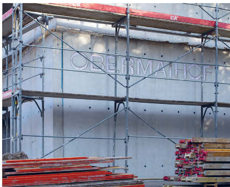
Im Obermaihof klettern die Stockwerke stetig in die Höhe. Die Oberfläche der Sichtbetonfassade mit dem markanten Siedlungsschriftzug wird vor Fertigstellung gesandstrahlt.
