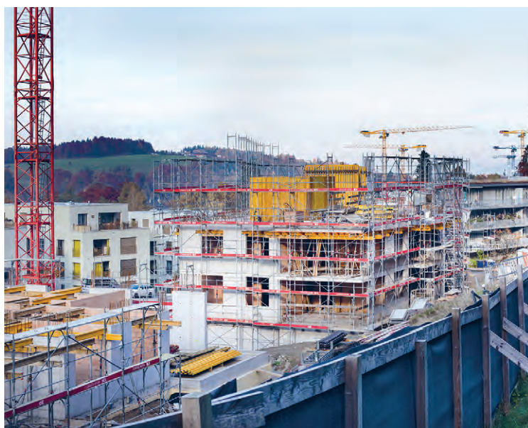
Im Obermaihof klettern die Stockwerke stetig in die Höhe. Die Oberfläche der Sichtbetonfassade mit dem markanten Siedlungsschriftzug wird vor Fertigstellung gesandstrahlt.
