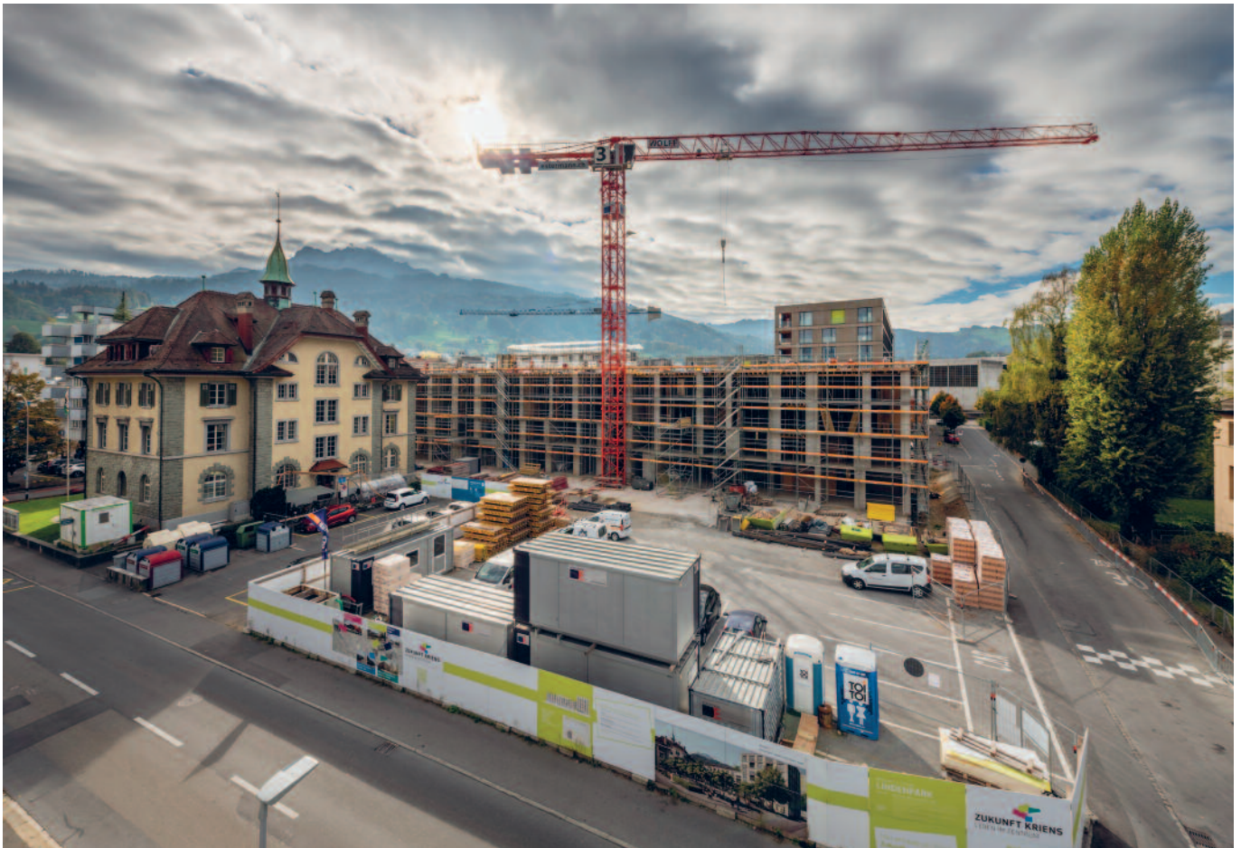
Das Herbstlicht lässt die Baustelle beim Gemeindehaus fast malerisch erscheinen. Der Lindenpark in Kriens könnte zu einem Vorzeigobjekt werden, wie Wohnen im Alter im besten Fall funktioniert und Spass macht.
