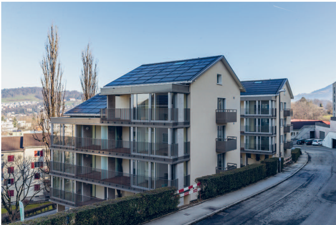
Mit der Sanierung der Weinberglistrasse 32 und 34 wurde die Gesamterneuerung der Siedlung Weinbergli abgeschlossen.
