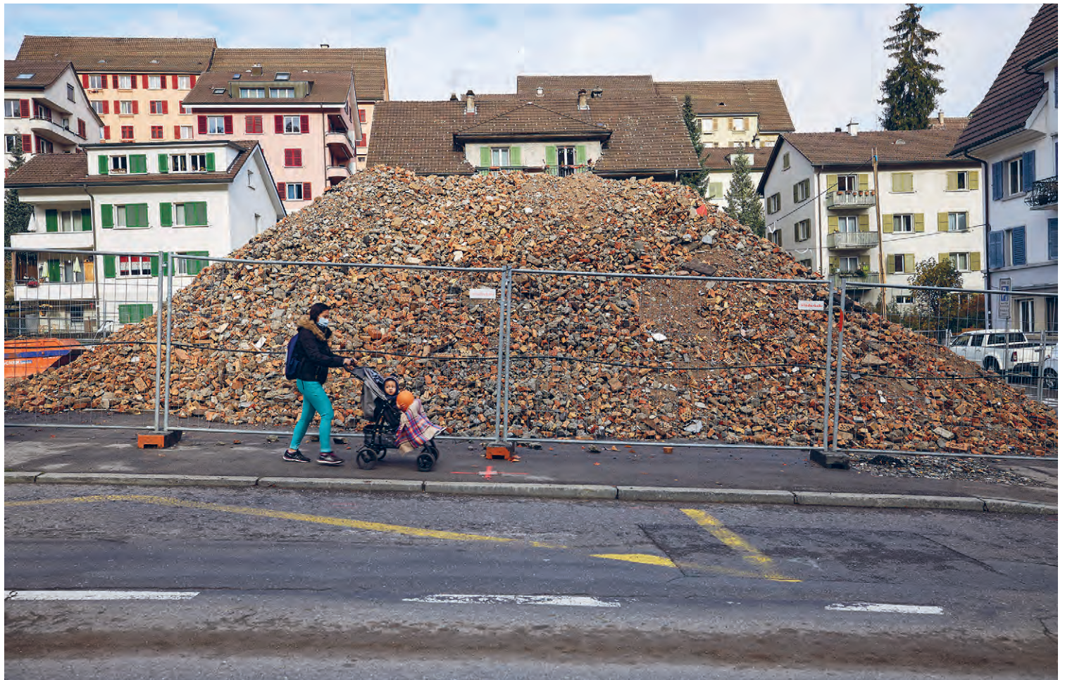
Ein Haufen Rückbaumaterial anstatt des «Bärenhauses» – die obere Bernstrasse Ende Oktober.
